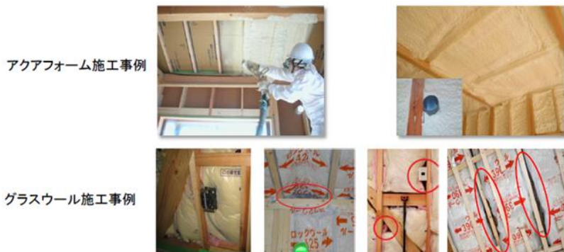
【図表 2】ウレタンフォームとグラスウールの施工事例
